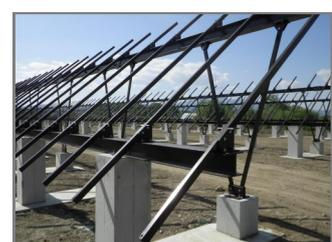
GFRP製パネル架台
