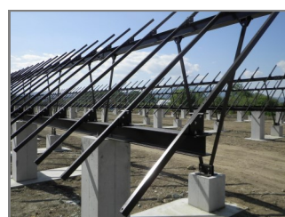
GFRP製パネル架台 (全区画)
