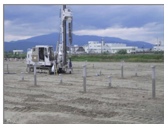
スパイラル杭基礎 (JCU区画)
